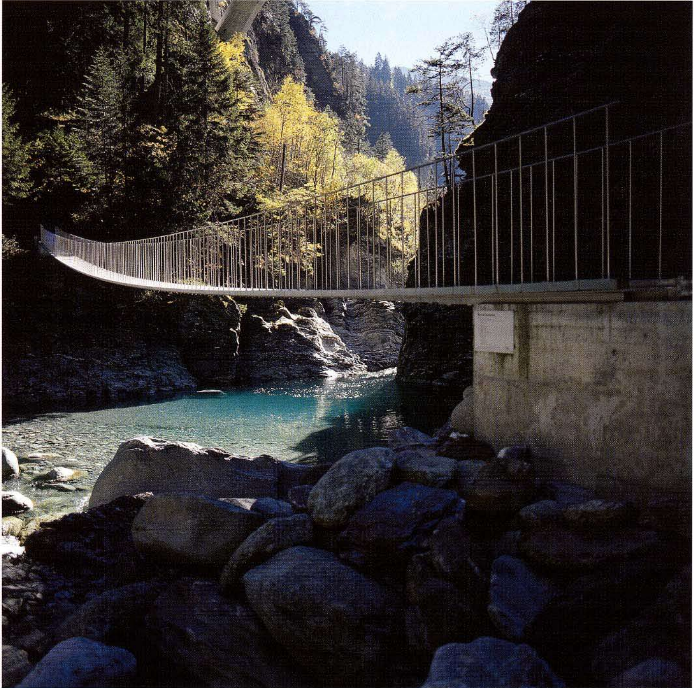
Hängebrücke ( Naturstein – Stahl – Verbundwerk) aus dem Jahre 2000 Pont suspendu (combinaison pietre naturelle – acier) réalisé en l'an 2000 Ponte sospeso (abbinamento pietra naturale e metallo) del 2000
