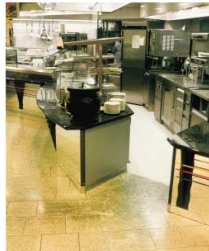
Bild 1: Hartnäckige Verschmutzung eines Granites im Restaurantbereich im Durchgang zur Küche.
