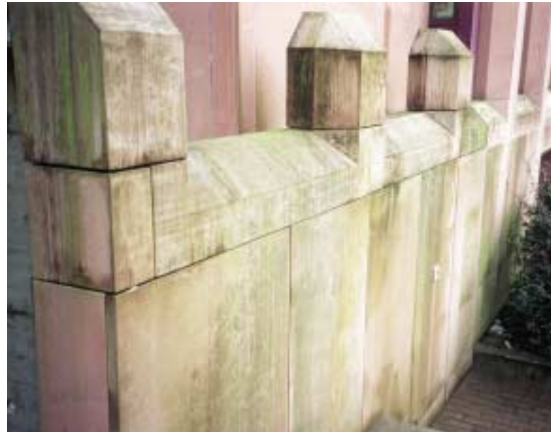
Bild 2: Veralgung eines feinkörnigen Sandsteines in schattiger Lage (Mainsandstein).
