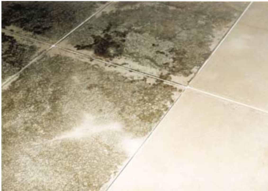
Bild 4: Verfärbung eines Quarzites infolge Huminstoffumwandlung in Zusammenarbeit mit zementösem Untergrund.
