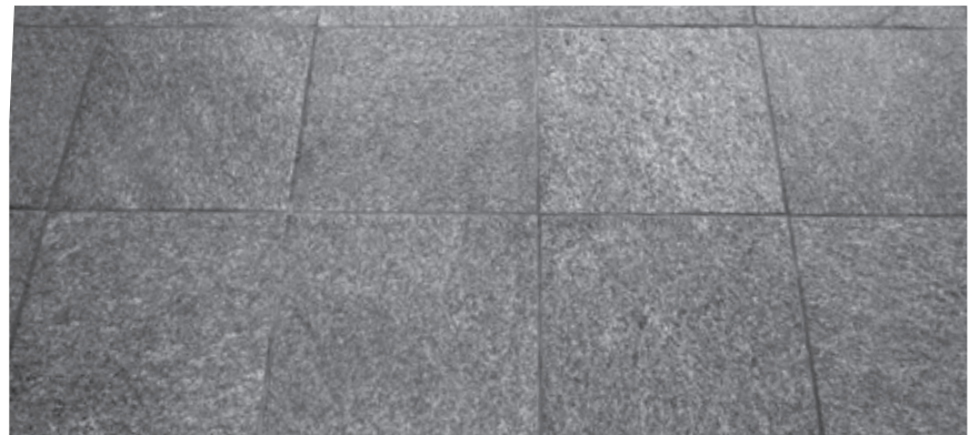
Verlegung mit Platten, die ein einheitliches Format haben (z.B. englisch oder Kreuzfugenverband).
