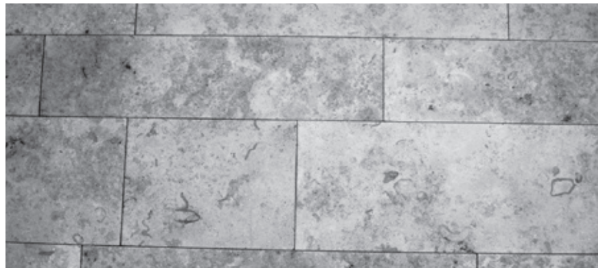
Verlegung in Bahnen mit freien Längen, mit gleich oder unterschiedlich breiten Bahnen.
