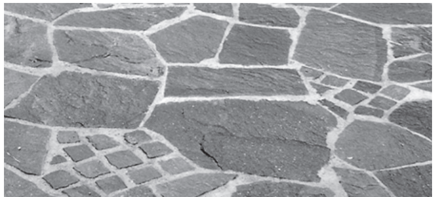
Formwilde Verlegung mit Polygonalplatten.
