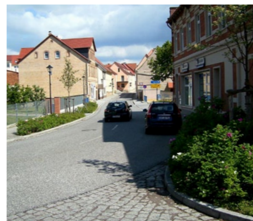
Asphaltbelag mit Übergang zu Naturwerksteinpflaster
