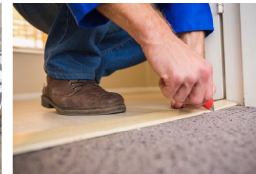
7: Elastischer Bodenbelag 8: Verlegung des Teppichbodens
