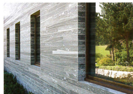
Zeitlos, modern und heute am Bau wieder vermehrt eingesetzt: Vorgemauerte Natursteinfassaden (Naturstein: Valser Quarzit).
