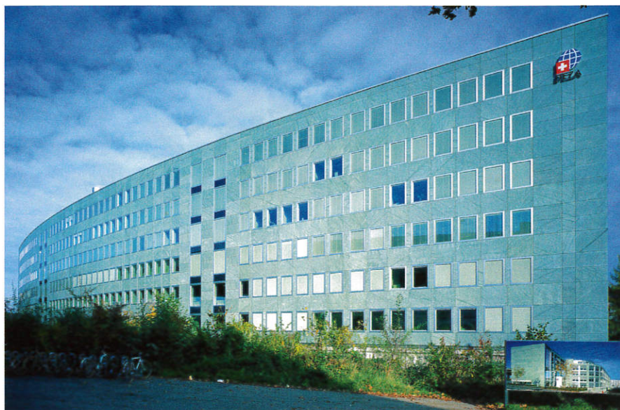
Repräsentative Fassade aus Schweizer Gneis an einem Verwaltungsgebäude (Naturstein: Andeer).
