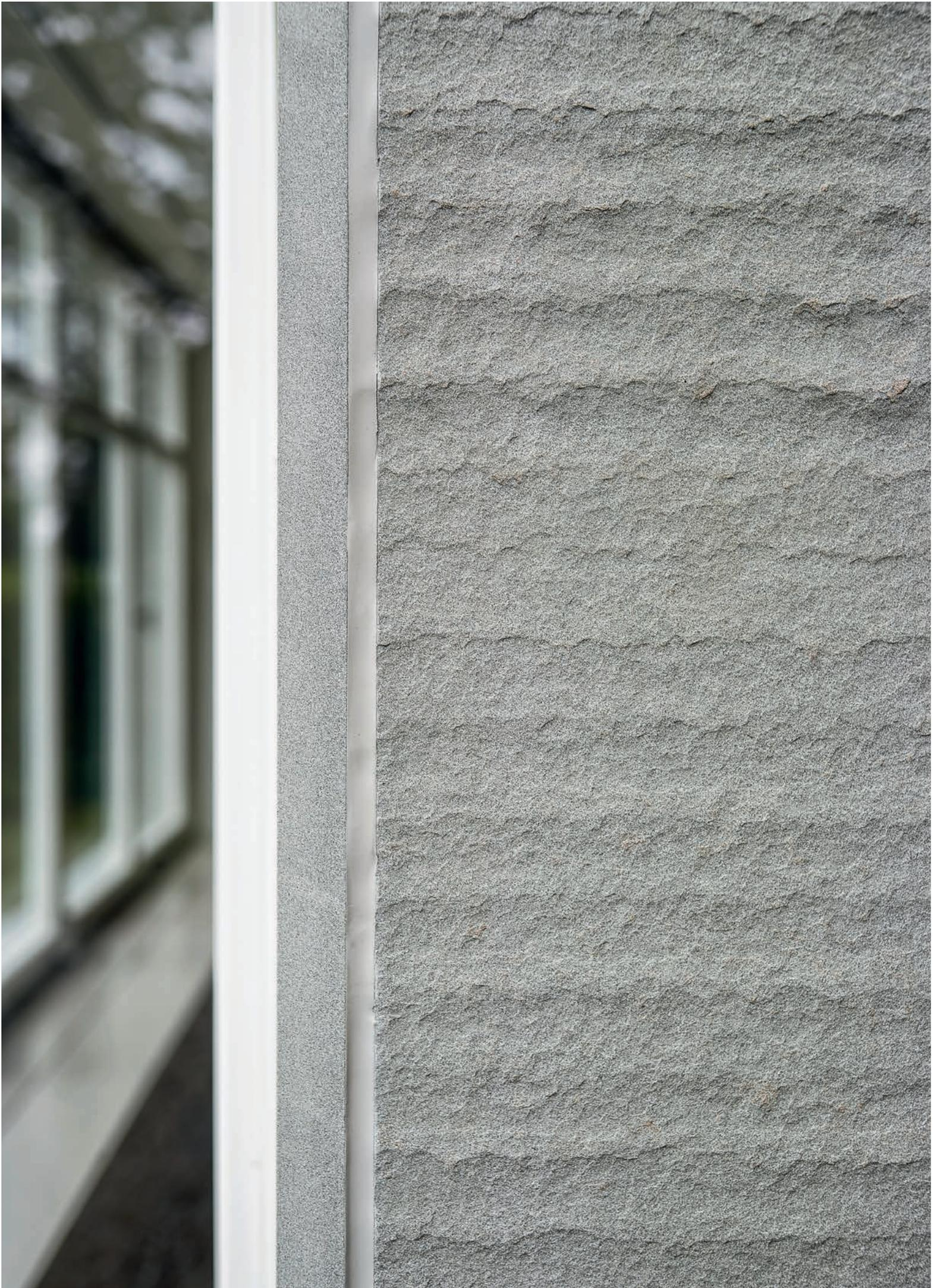
Der geflammte Rorschacher Sandstein schützt und trägt als Teil einer Verbundkonstruktion eines Anbaus in Obfelden.
