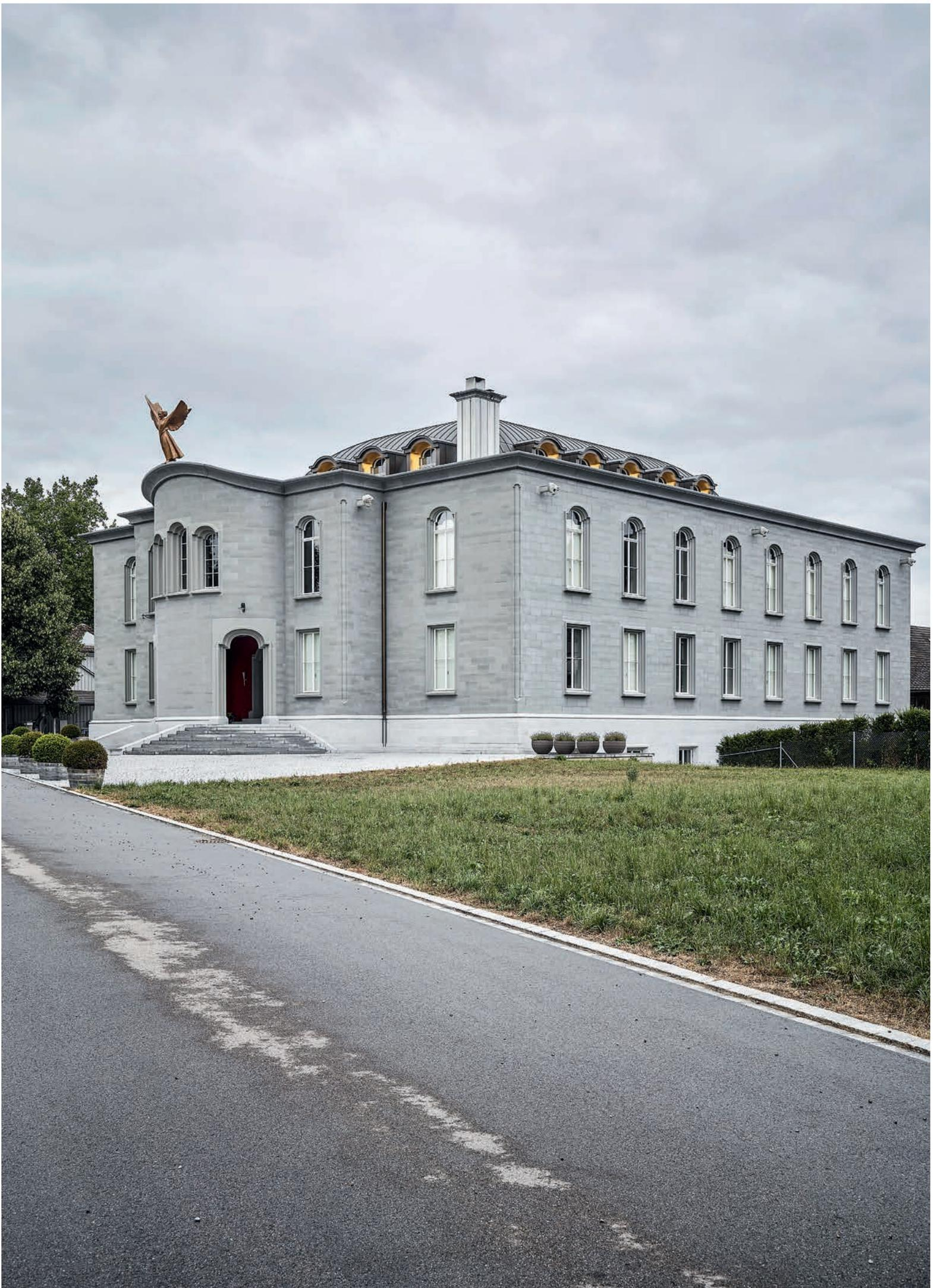
Gebaut für 300 Jahre: Der Modelhof ist ein architektonisches Kuriosum, doch energietechnisch ist die massive Verbundkonstruktion aus Sandstein und Vollklinker interessant.
